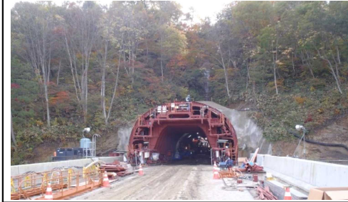
前波トンネル
