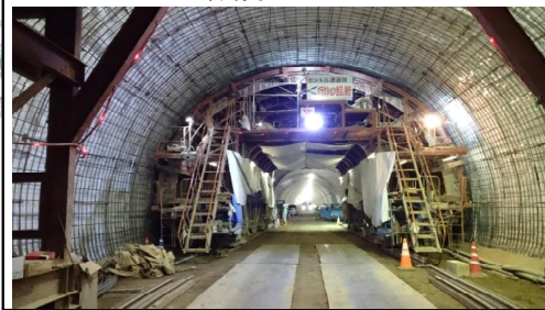
岩清水トンネル
