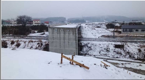
津谷跨線橋付近(酒田方面)
