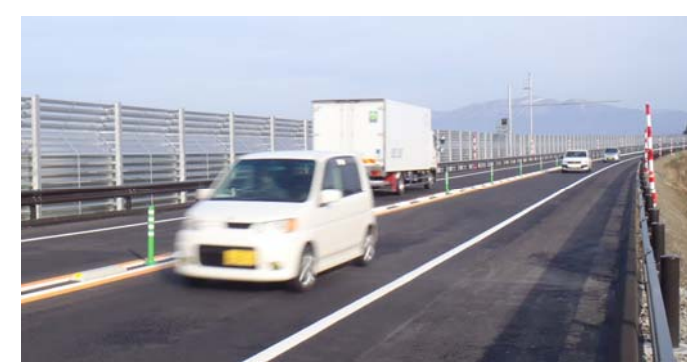
新庄古口道路(本合海～升形) L=2.4km 開通後の状況
