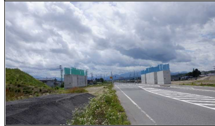
川西IC橋 付近
