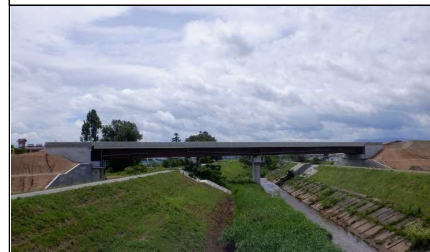
元宿川橋 付近
