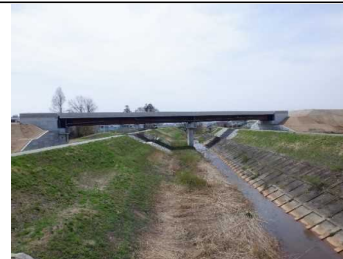
元宿川橋 付近
