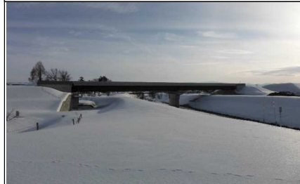
元宿川橋 付近
