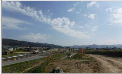
南陽市竹原 地内 (米沢方面)
