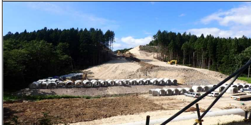
小国地区～岩井沢地区（現在施工箇所）
