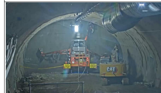
新及位トンネル（削孔状況）
