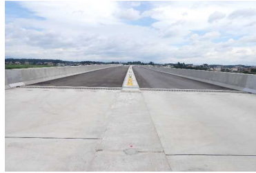
泉田川橋付近(金山方向)
