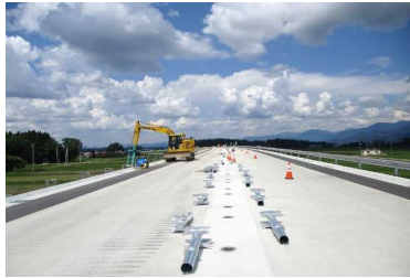
十日町(谷地小屋東)地区(金山方向)
