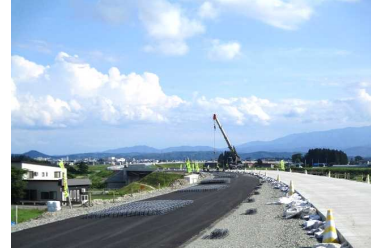
泉田川橋(尾花沢方向)
