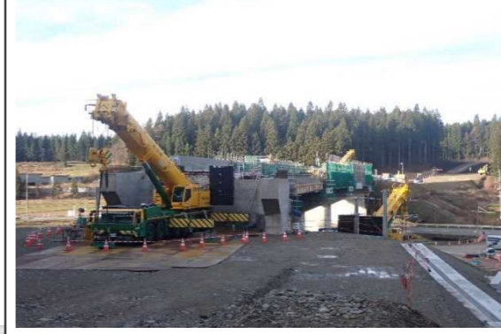
泉田大橋付近(金山方向)
