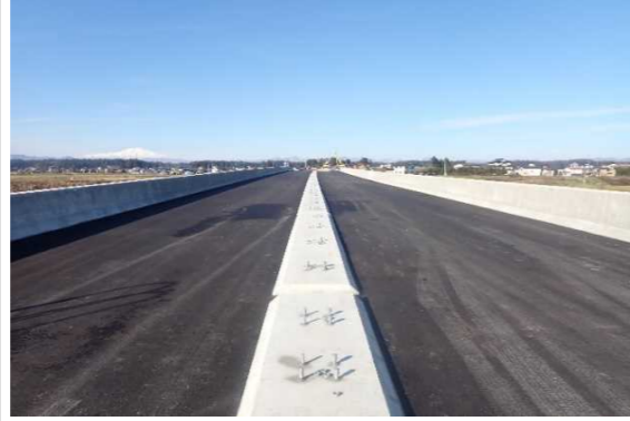
泉田川橋付近(金山方向)
