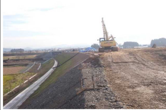
泉田川橋(尾花沢方向)
