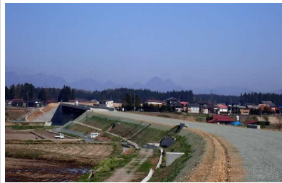
泉田川橋付近(金山方向)
