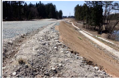
十日町西山中地区(尾花沢方向)
