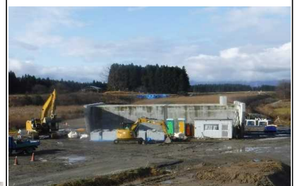
昭和地区 (尾花沢方向)
