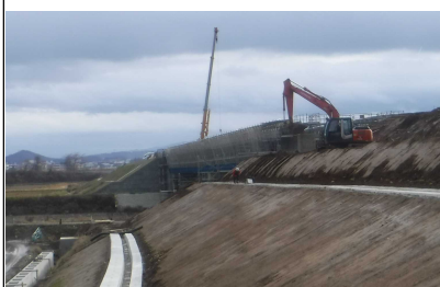
泉田川橋 (尾花沢方向)
