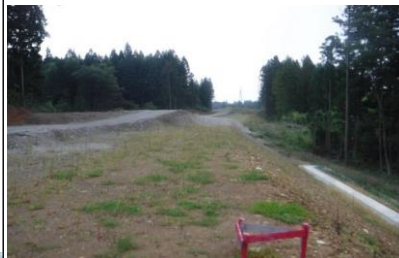
十日町西山中地区 (尾花沢方向)
