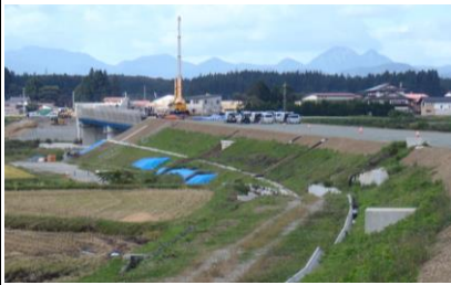
泉田川橋付近 (金山方向)
