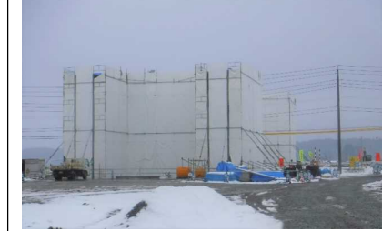
昭和IC橋付近 (金山方面)
