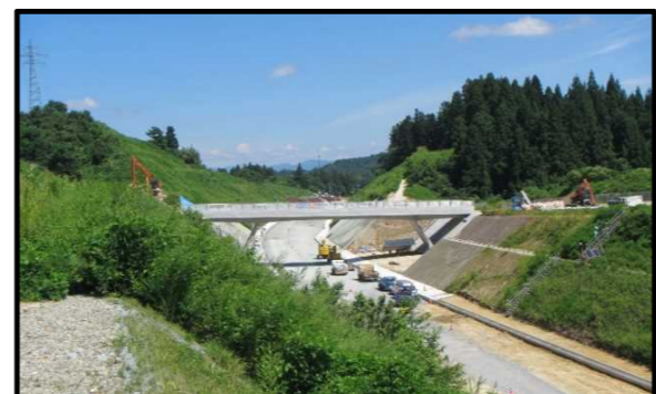
村山跨道橋(新庄方向)
