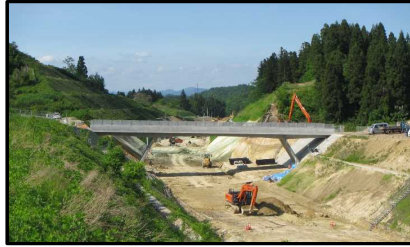
村山跨道橋(新庄方向)
