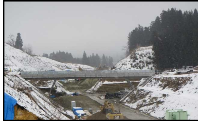
村山跨道橋(新庄方向)
