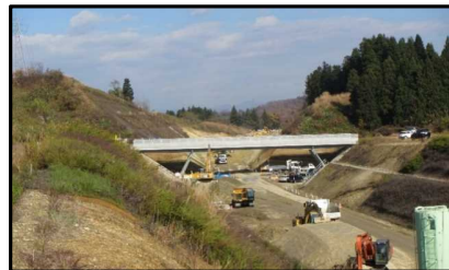
村山跨道橋(新庄方向)
