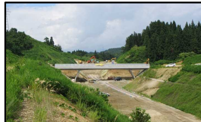
村山跨道橋(新庄方向)
