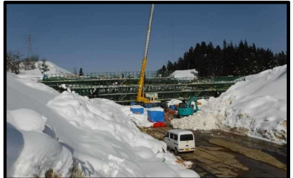
村山跨道橋(新庄方向)
