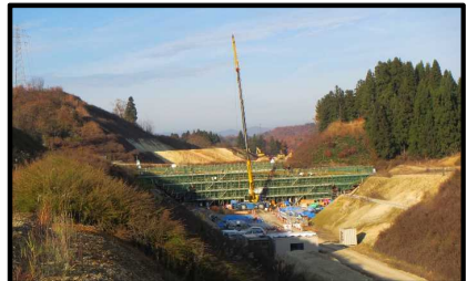
村山跨道橋(新庄方向)
