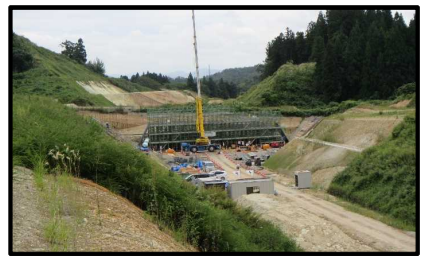
村山跨道橋(新庄方向)
