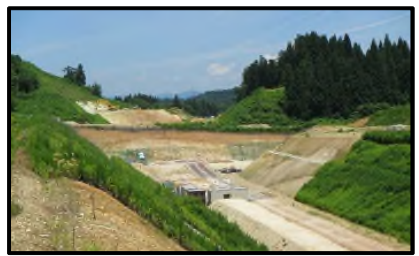
村山跨道橋(新庄方面)
