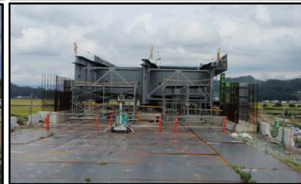
袖崎こ道橋(新庄方面)
