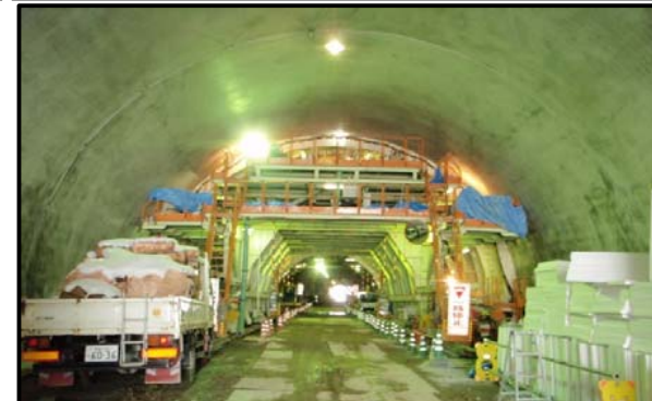
村山トンネル
