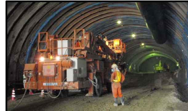
村山トンネル
