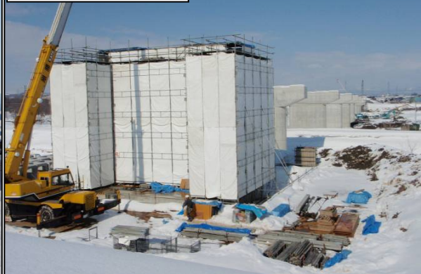
米沢大橋(山形方向)
