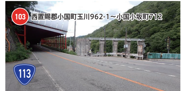
【主な危険な箇所】
