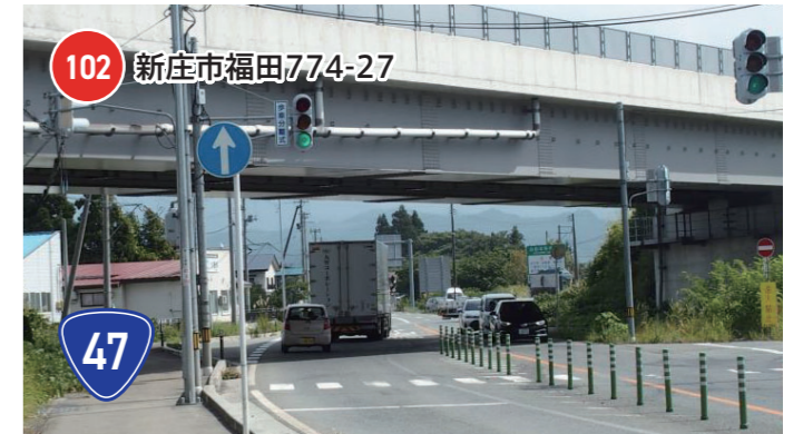
【主な危険な箇所】
