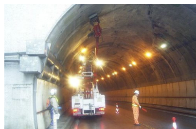
写真2-2 トンネル点検状況
