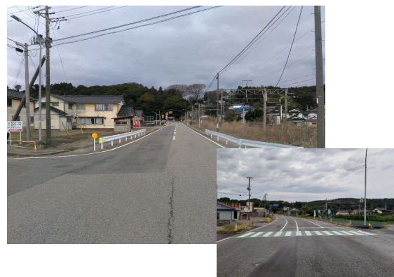
【対策】撤去（横断歩道に集約）
