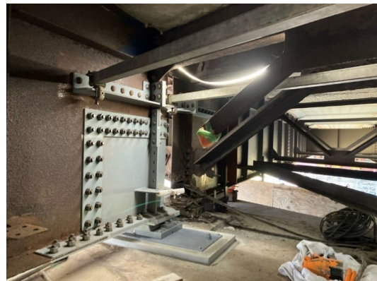
【対策】当て板補修、支承取替
