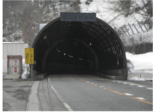
【全景】関山トンネル
