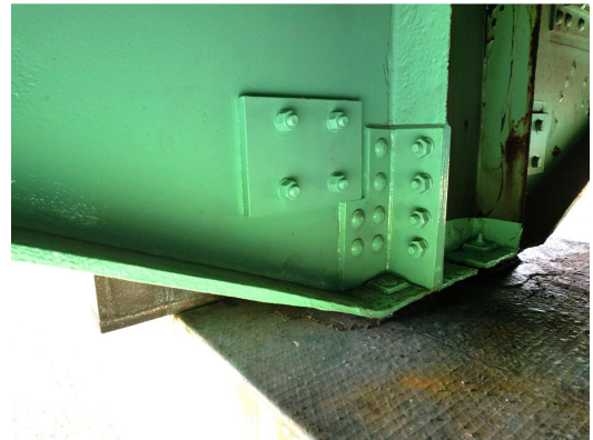
【対策】主桁のあて板補修
