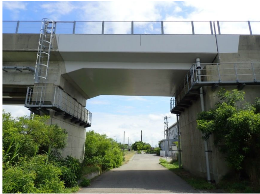
【対策】断面修復+はく落対策
