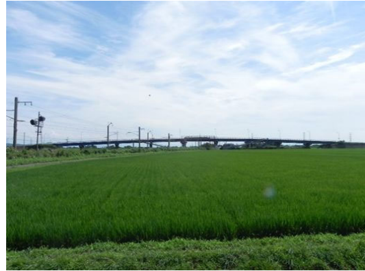
【全景】福島跨線橋
