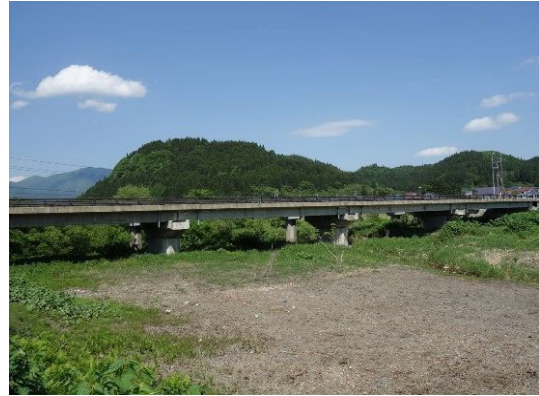
【全景】新絹出川橋
