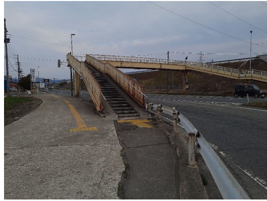
【全景】中田横断歩道橋
