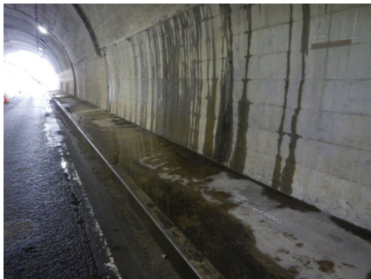
【損傷】漏水
