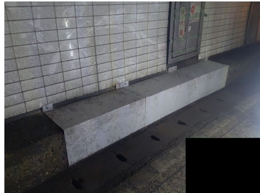
【対策】撤去・新設
