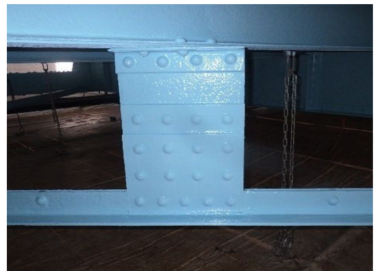
【対策】当て板補修
