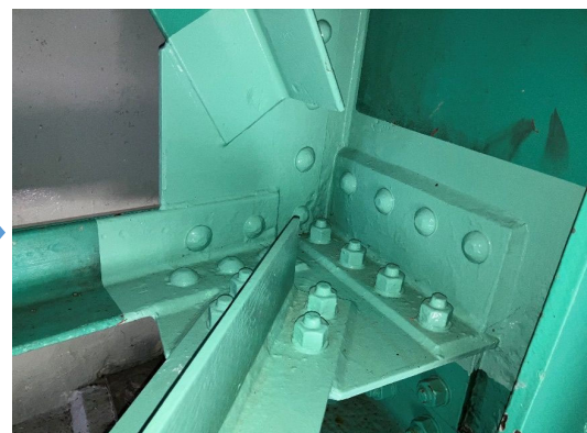
【対策】 鋼桁補強工(あて板・部材交換)
