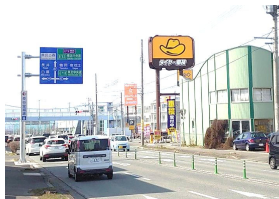
【対策】 スマートインターチェンジの新規標識と ともに片持式標識に更新
