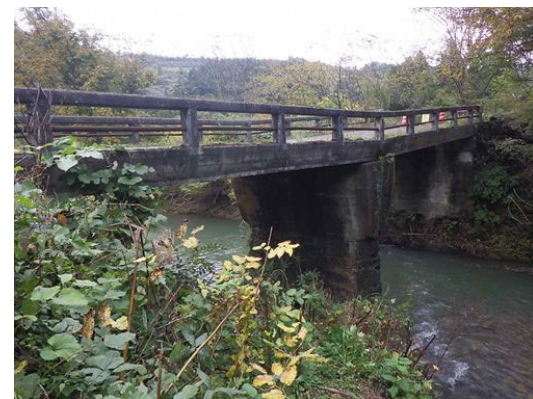
【全景】大入間川橋
