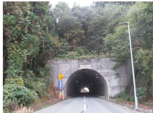
【全景】升形トンネル
