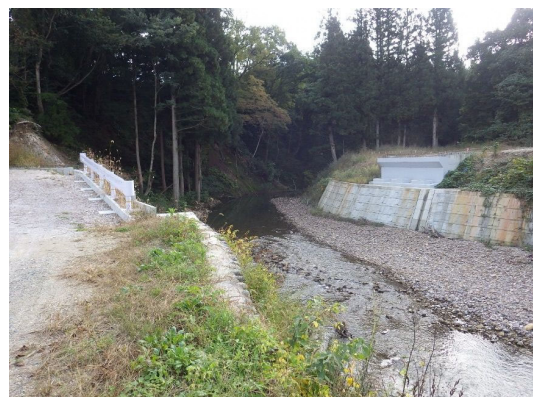
【対策】撤去（架替対策中）
