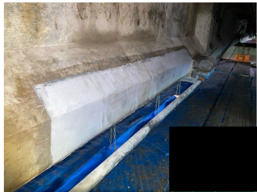
【対策】断面修復
