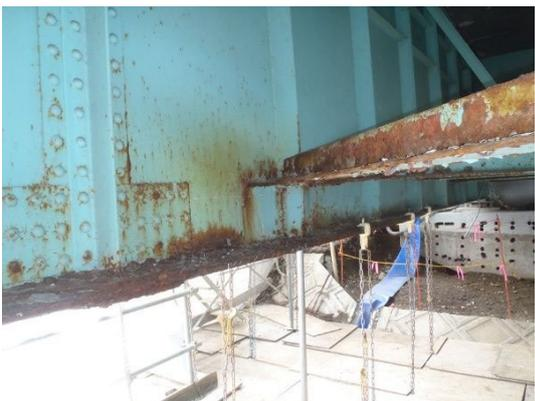
写真4-2 【損傷】主桁の腐食
