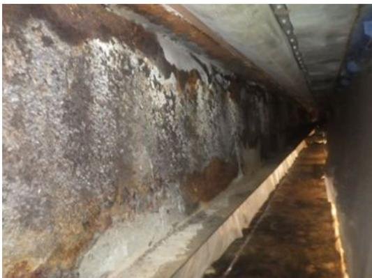
写真4-11 【損傷】主桁の腐食、防食機能の劣化
