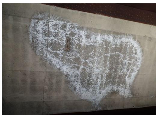
写真4-28 RC床版のひびわれ
