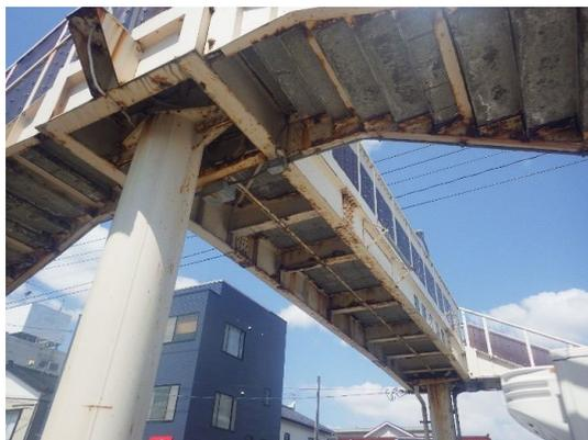
写真4-26 【損傷】鋼材の腐食
