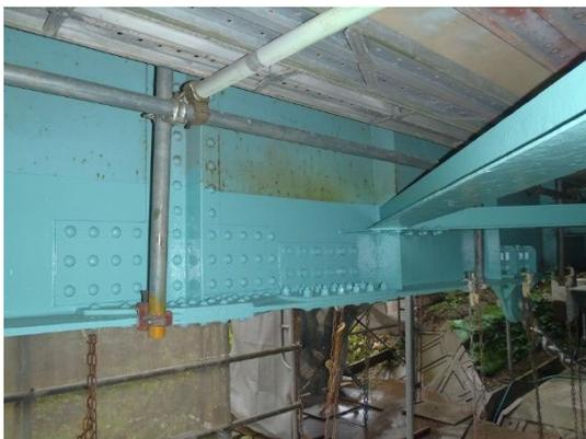
写真4-3 【損傷】当て板補修・再塗装
