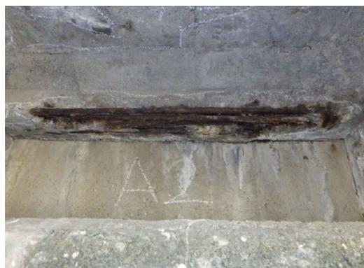
写真4-29 横桁の全般的な剥離・鉄筋露出
