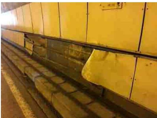
写真4-23 【損傷】内装板の破損
