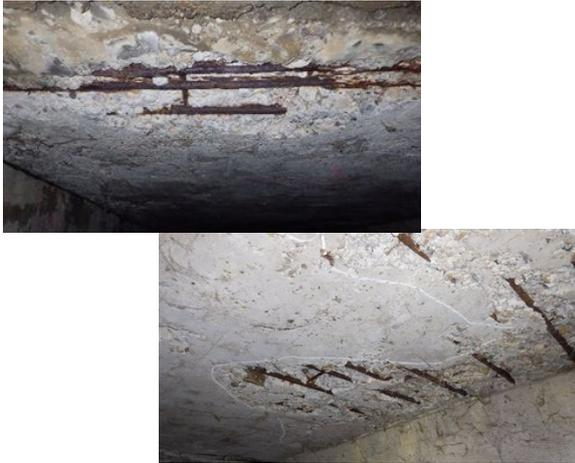
写真4-8 【損傷】床版の剥離・鉄筋露出
