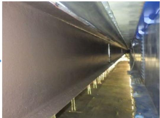
写真4-12 【対策】主桁再塗装
