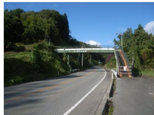
写真4-40 【全景】滝野横断歩道橋
