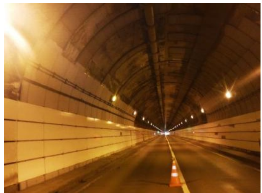
写真4-30 【対策】漏水防止版交換
