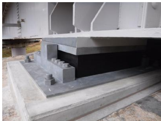
写真4-15 【対策】 支承取替
