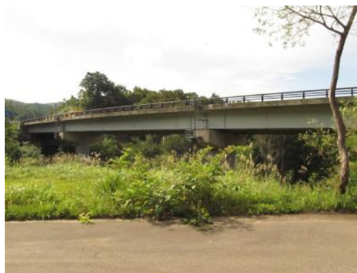
写真4-13 【全景】八紘沢橋
