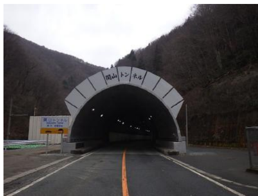
写真4-31 【全景】関山スノーシェルター
