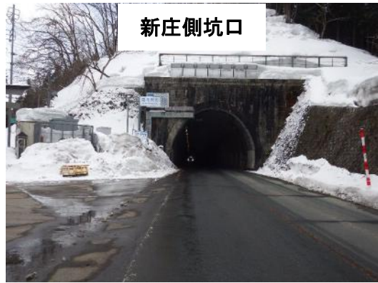
写真4-25 【全景】猿羽根トンネル
