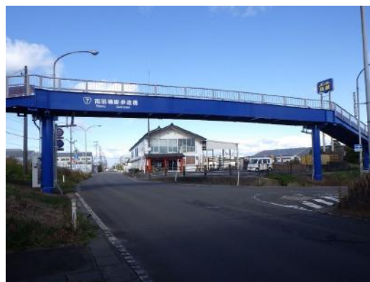
写真4-34 【全景】両羽横断歩道橋 （R2架替え後）
