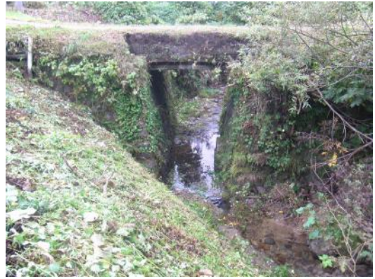
写真4-7 【全景】武川沢橋
