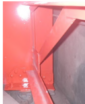
写真4-12 【対策】当て板補修
