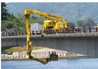
写真2-1 橋梁点検状況
