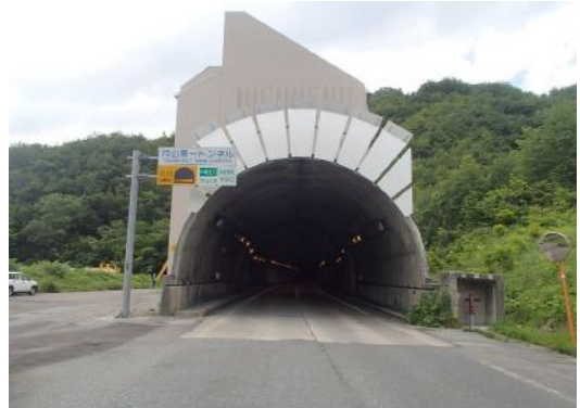
写真4-28 【全景】月山第一トンネル
