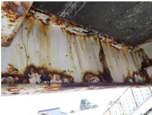
写真4-38 【損傷】腐食
