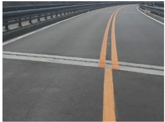
写真4-3 【損傷】伸縮装置取替
