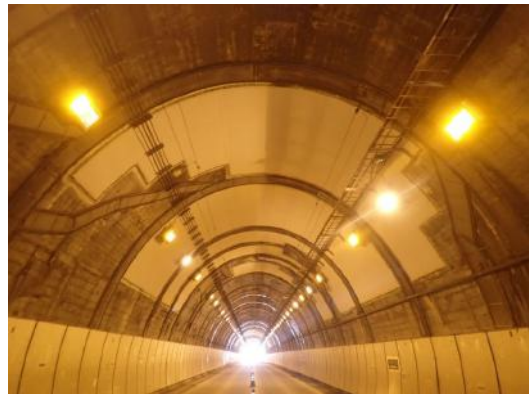
写真4-27 【対策】炭素繊維内蔵パネル設置
