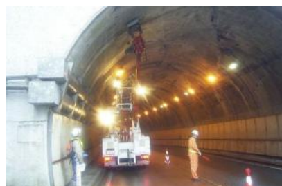
写真2-2 トンネル点検状況
