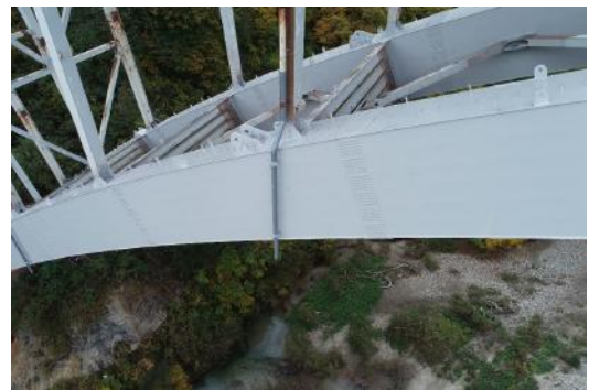
写真4-6 【対策】 アーチリブ塗装、配水管交換
