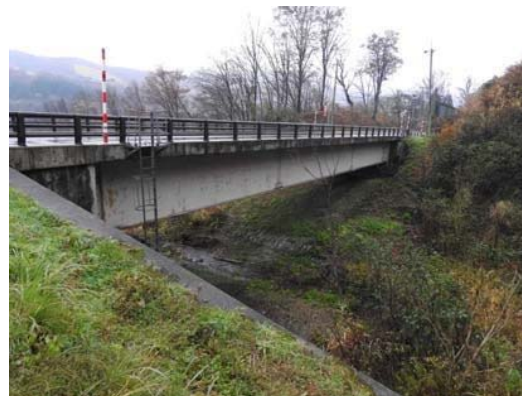
写真4-7 【全景】鶴の里橋
