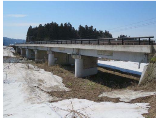
写真4-19 【全景】仁田山橋
