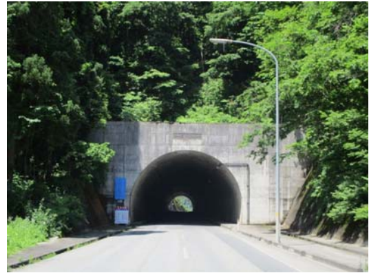
写真4-13 【全景】升形トンネル
