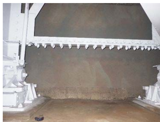
写真4-12 【対策】 支承金属溶射、当て板補修
