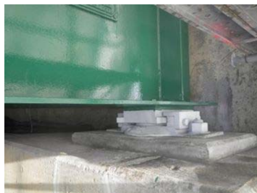
写真4-3 【対策】 支承金属溶射、再塗装
