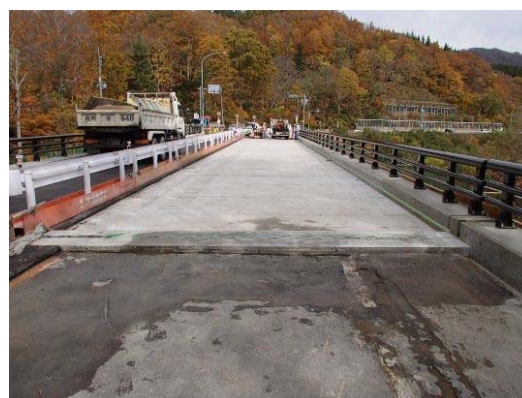
写真4-9 【対策】床版取替
