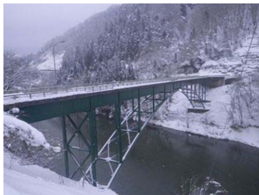
写真4-1 【全景】大船木橋
