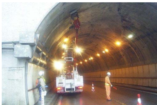
写真3-2 トンネル点検状況
