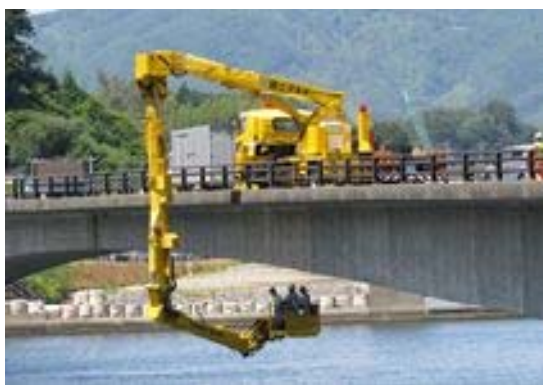
写真3-1 橋梁点検状況
