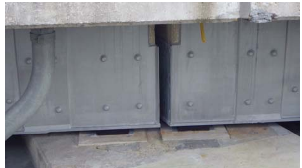
写真4-21 【対策】 主桁補修（鋼板接着）
