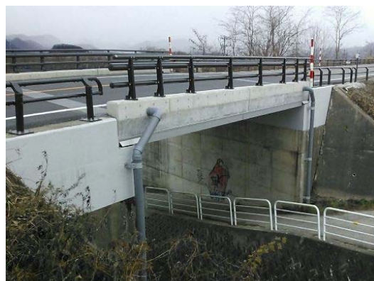
写真4-6 【対策】 地覆修復・防護柵更新
