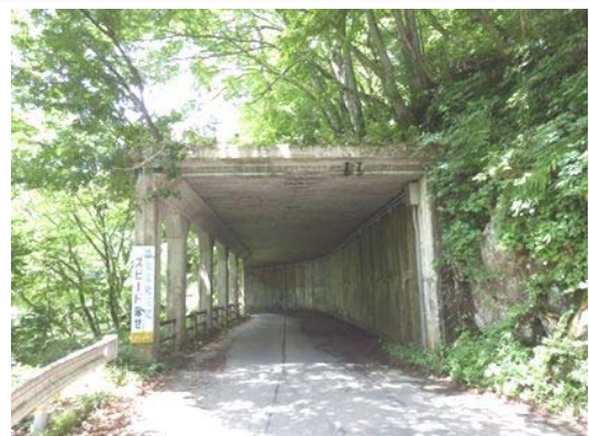
写真4-16 【全景】松沢シェッド
