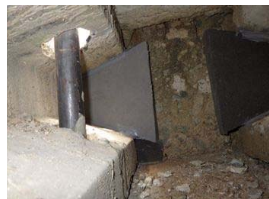
写真4-18 【対策】 アンカーバーの部材交換
