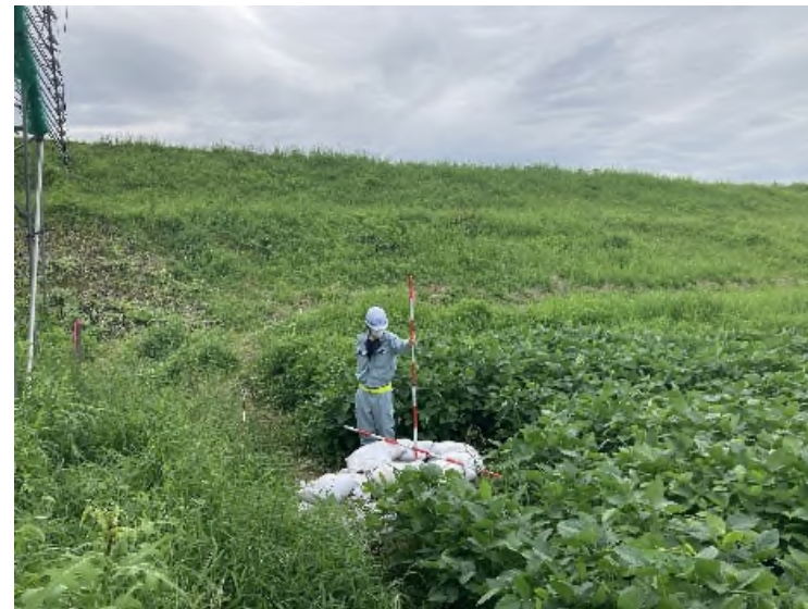
漏水箇所調査状況(河北町)
