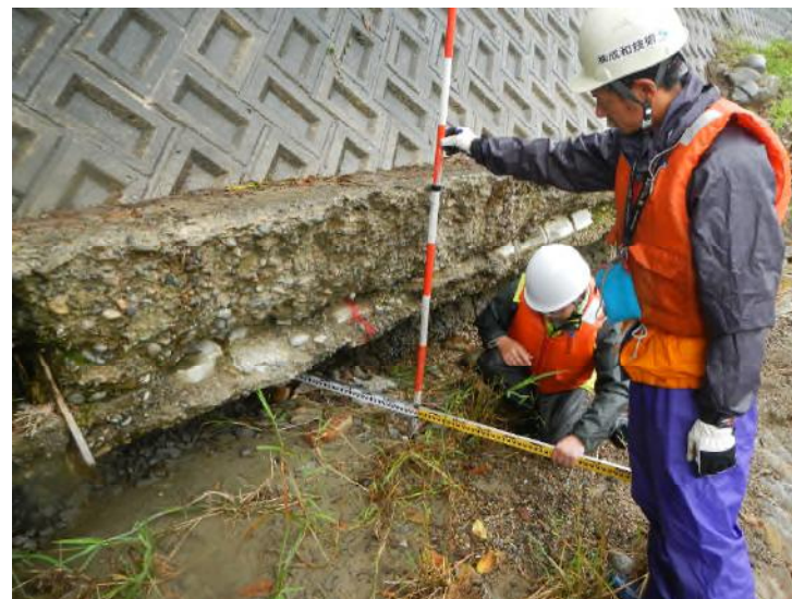
護岸基礎洗掘箇所調査状況(朝日町)
