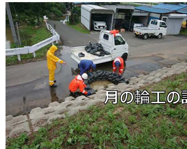
堤体漏水の発生状況 (川西町)
