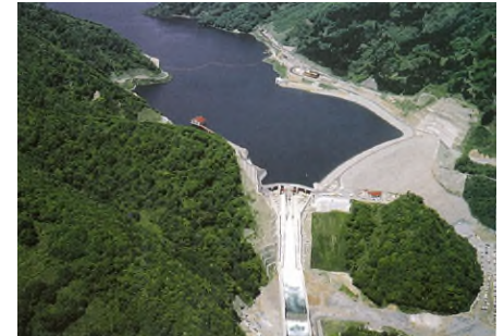
寒河江ダム／西川町 (着工昭和47年／完成平成2年)
