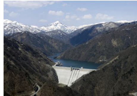
長井ダム／長井市 (着工昭和59年／完成平成23年)
