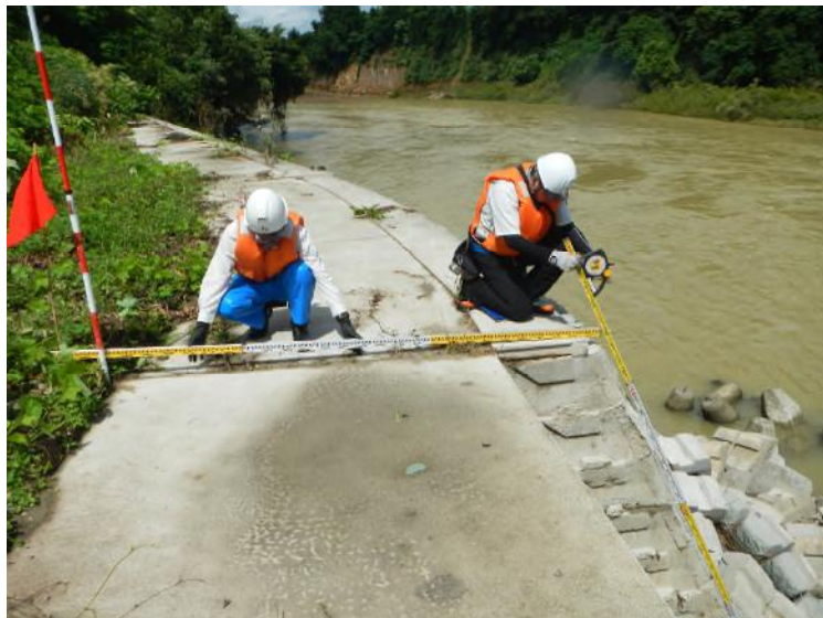
護岸損壊箇所調査状況(朝日町)
