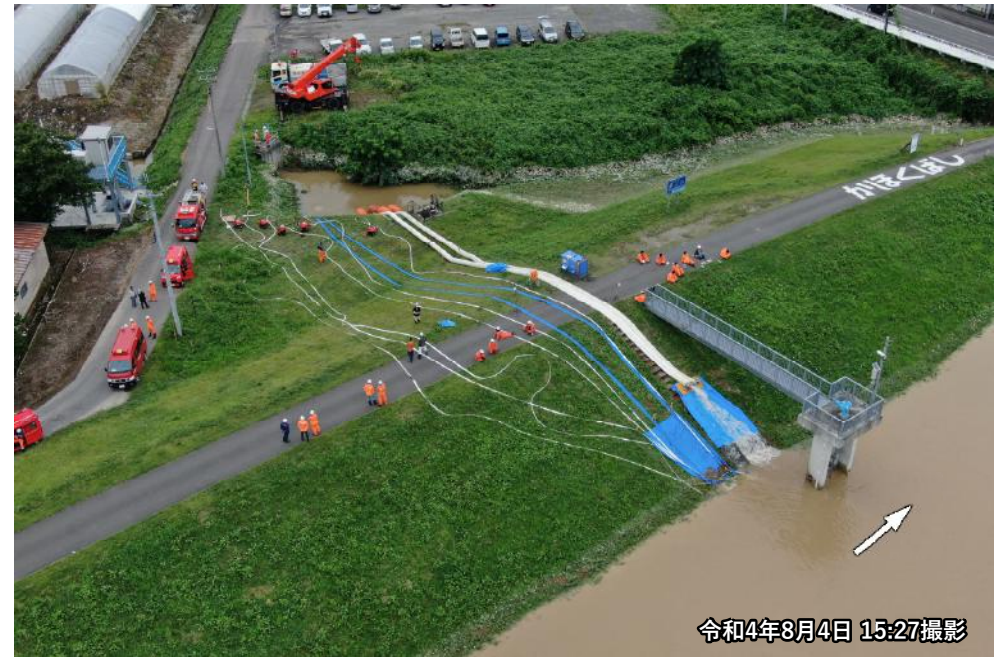
かほくちよう ながさき 河北町押切地区 水防団・国土交通省による内水排除作業
