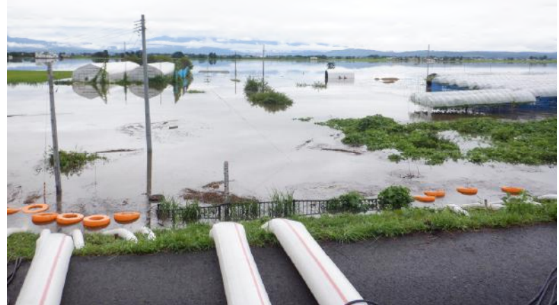
▲川西町鬼神川水門 排水ポンプ車稼動状況
