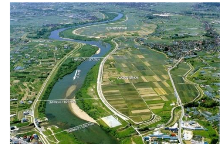
大久保遊水地／村山市・河北町 (着工昭和50年／完成平成9年)
