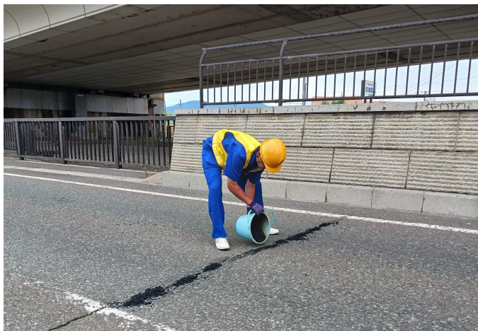
道路補修体験（国道13号）
