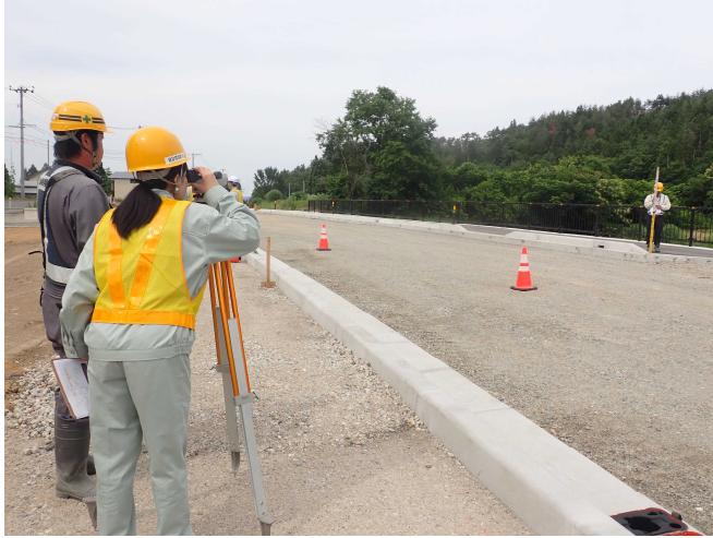
国道113号の工事現場での監督体験
