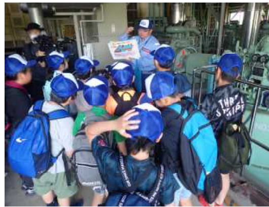
排水機場見学
