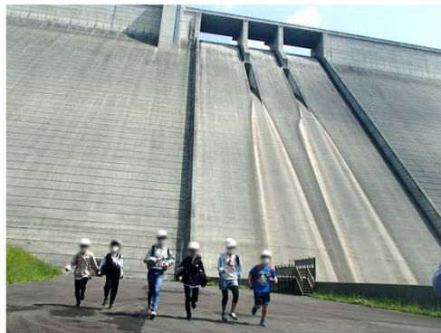
長井ダム見学
