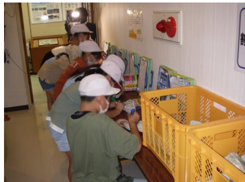
工事材料へのメッセージ記入状況
