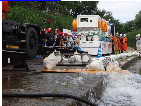
排水ポンプ見学
