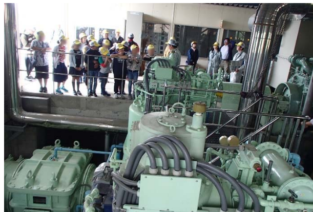
排水機場について説明
