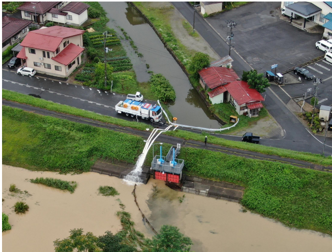
令和4年8月出水 長井市木蓮川水門 排水ポンプ車 60m 3 /min × 1台
