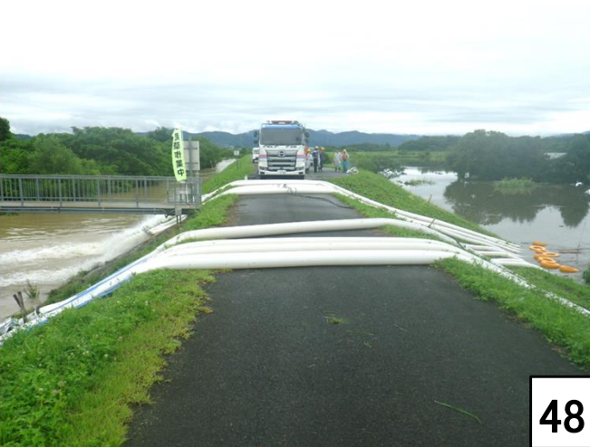
令和4年8月出水 南陽市鬼神川水門 排水ポンプ車 60m 3 /min × 1台
