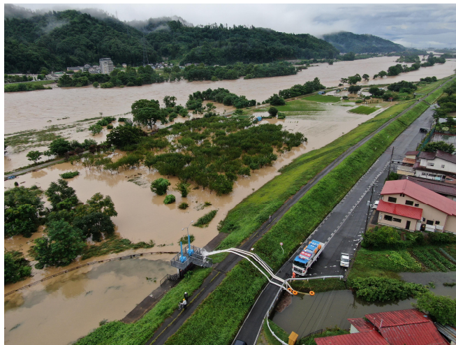
令和4年8月出水 長井市木蓮川水門 排水ポンプ車 60m 3 /min × 1台
