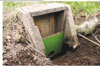
排水柵に調整板を設置した様子
