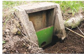
田んぼダム（排水柵に調整板を設置）
