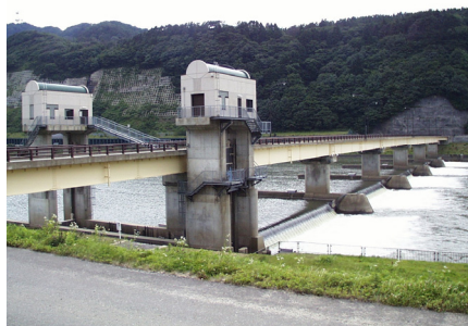
最上川さみだれ大堰
