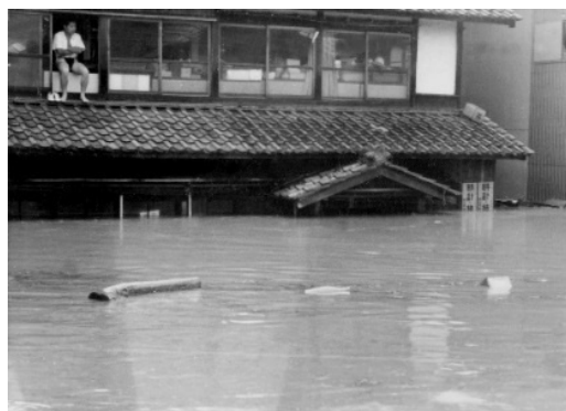
最上川の増水による家屋浸水状況 (戸沢村古口地区)
