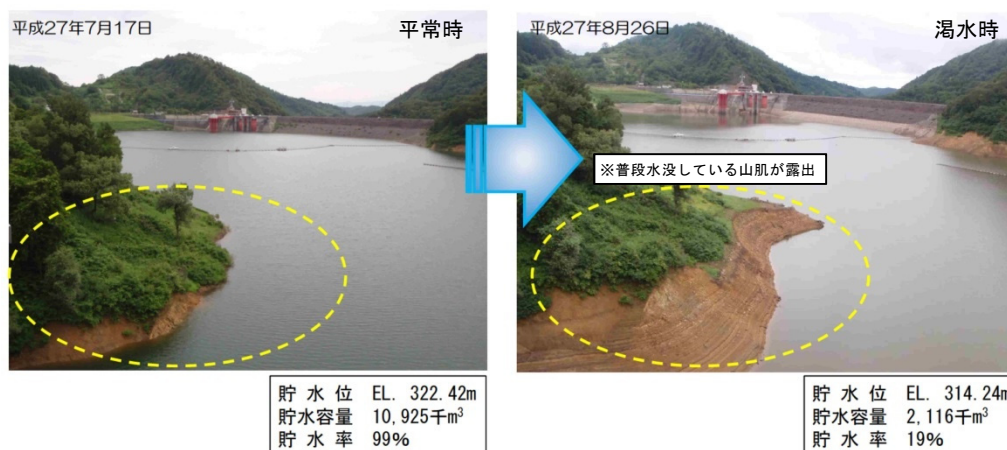
白川ダム貯水状況
