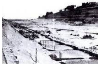
放水路開削工事の様子（昭和8年）
