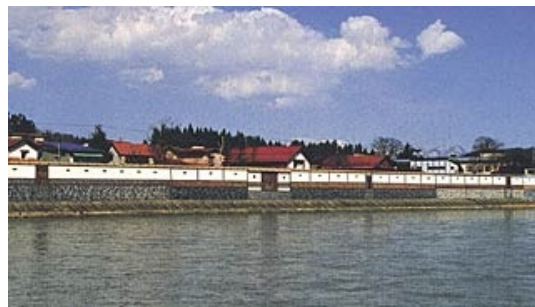
大石田特殊堤修景
