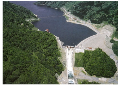
寒河江ダム (平成 3 年完成)
