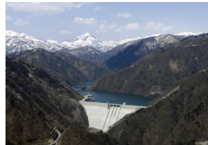
長井ダム (平成 23 年完成)
