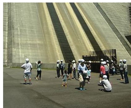
長井ダム見学
