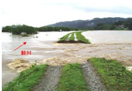
鮭川の増水による堤防決壊状況 (鮭川村観音寺地区)
