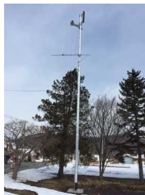
【防災行政無線の整備】 屋外拡声子局76箇所設置 戸別受信機を避難所、福祉施設、音声 難聴世帯へ設置
