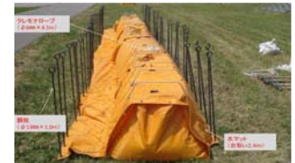
水マット工法
