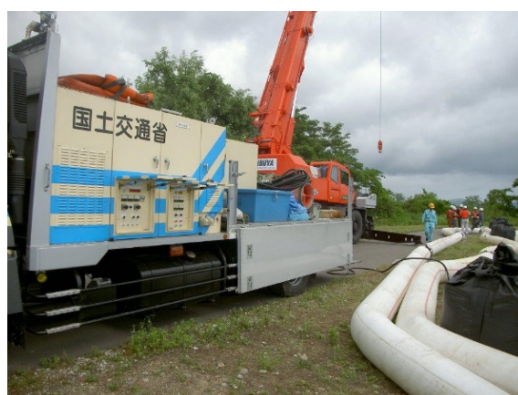
排水ポンプ車設置、排水訓練 (平成 27 年)
