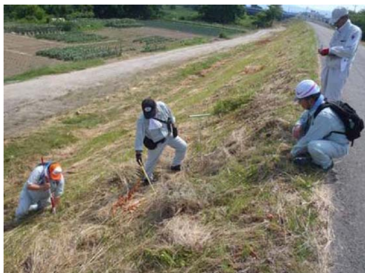
事務所職員による堤防点検
