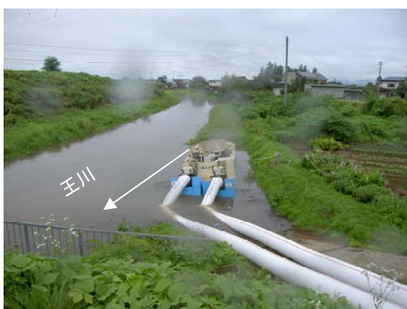
排水ポンプ車による内水排除 (山形市榎沢地区 (H25. 7. 18) )
