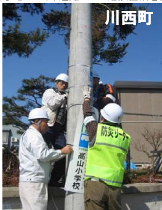
標識の設置状況
