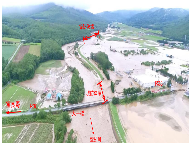
堤防の決壊による氾濫状況(石狩川水系空知川)
