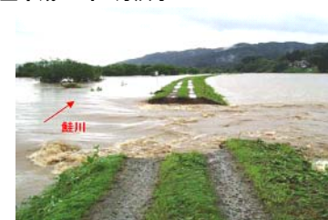
鮭川の増水による堤防決壊状況 (鮭川村観音寺地区)
