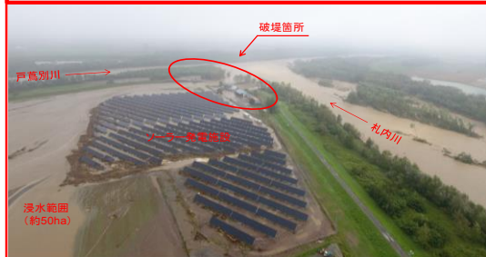
札内川の堤防決壊状況(帯広市)
