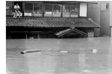
最上川の増水による家屋浸水状況 (戸沢村古口地区)
