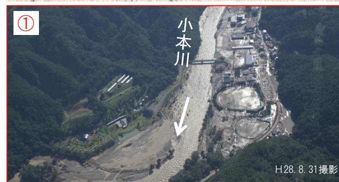
乙茂地区の被災状況
