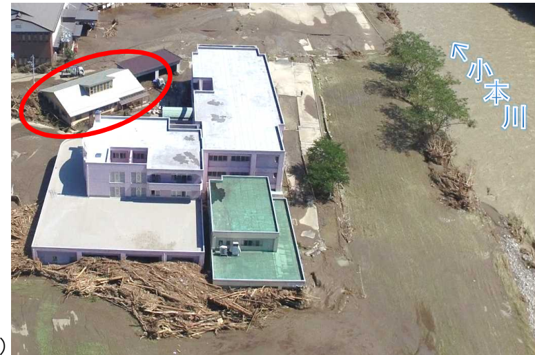
岩手県岩泉町の認知症高齢者グループホーム。台風10号により小本川が氾濫し、入居者9名の全員が死亡した。
