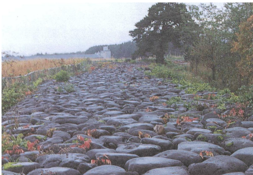
写真 3 直江石堤（米沢市赤崩地区）
