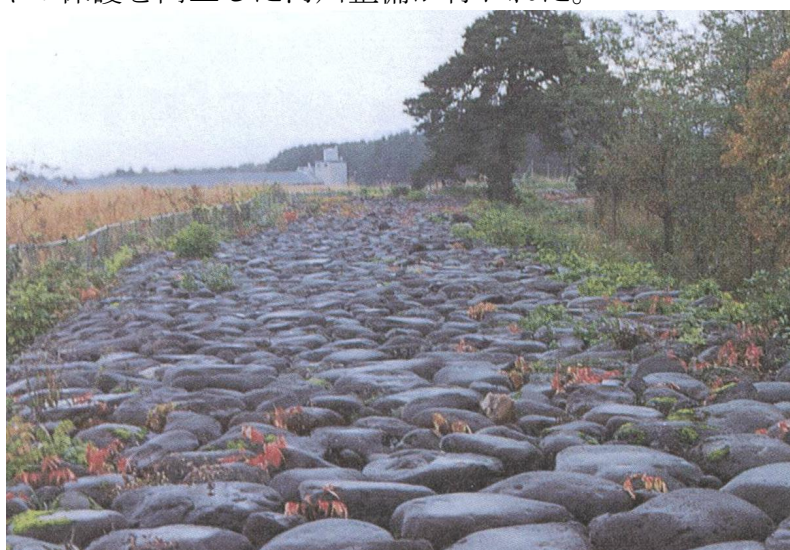
写真3 直江石堤 (米沢市赤崩地区)
